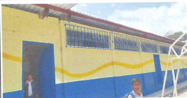
Foto: 1 Colocación de canales
