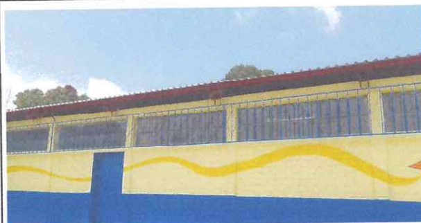
Foto: 2 Colocación de canales
