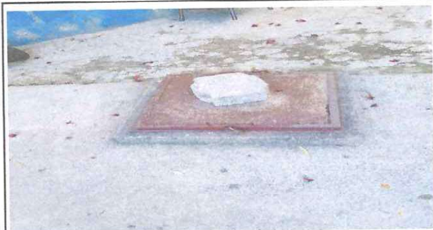
Foto: 3 Mejoramiento de tapadera de cisterna
