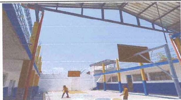
Terminar de techar la cancha de baloncesto
