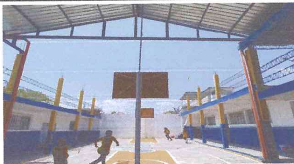
Terminar la Estructura de techo
