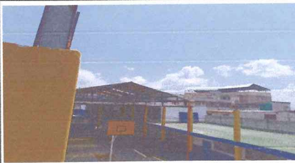
Completar la estructura del techo de la cancha
