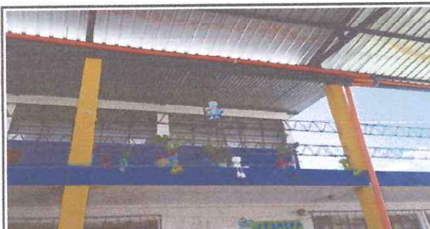
Mantenimiento de barandas
