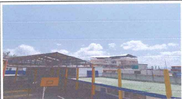
Colocar sobre esas bases la estructura del techo
