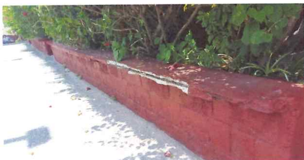
Foto: 5, Mantenimiento de bordillo en jardinera.
