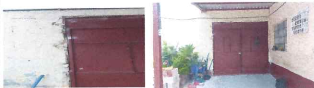
Foto: 1, Mejoramiento de porton principal.
