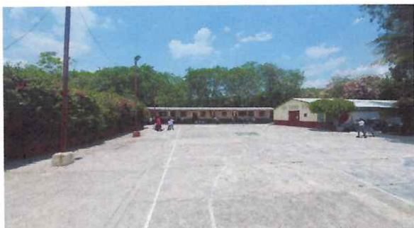
Foto: 3, Instalacion de lamparas led para lumbrado de patio.
