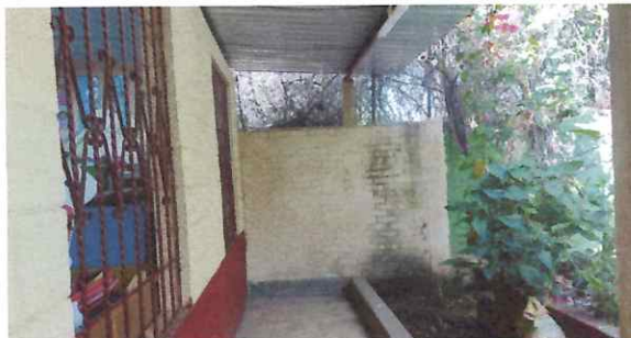
Foto: 4, Repello en paredes interior y exterior de preprimaria en 3 aulas.
