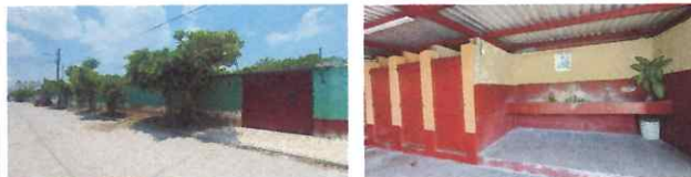
Foto: 2, Pintura en muros interiores y exteriores.
