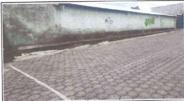
Foto: 16 Cerrido e impermeabilización de salones lado fuera
