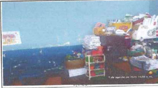
Foto: 4 Impermeabilización en salón
