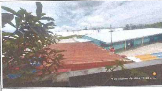
Foto: 6 Cambio de lámina
