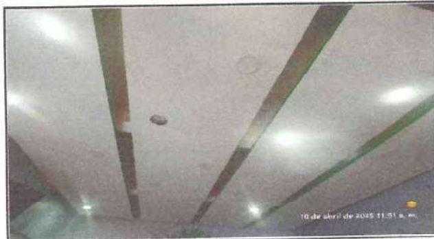
Foto: 17 Cambio del sistema eléctrico
