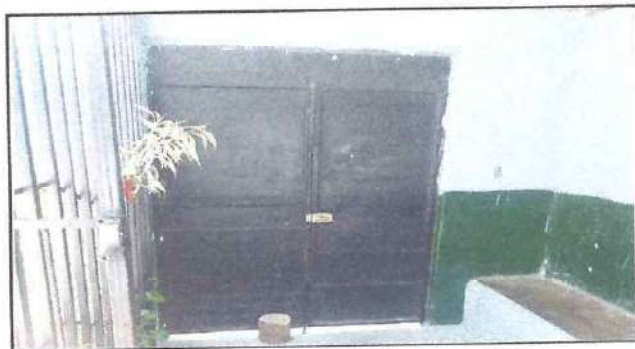
Foto: 19 Remozamiento de Puerta principal
