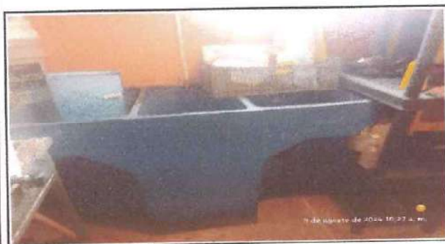
Foto: 11 Cambio de pila a salón que se le reemplazará lámina y drenaje
