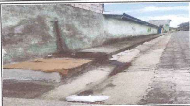
Foto: 14 Impermeabilización de salones parte de afuera
