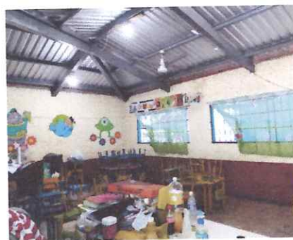
Foto: 4, Sustitución de cableado eléctrico y mantenimiento de balcones.
