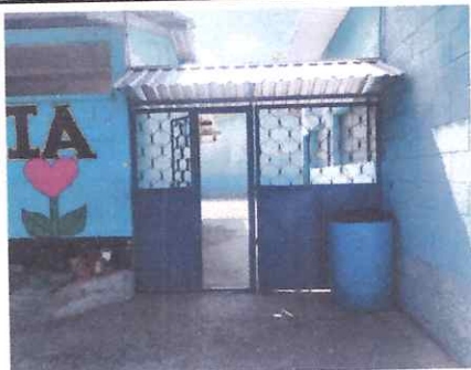
Foto: 5, Mantenimiento de porton.
