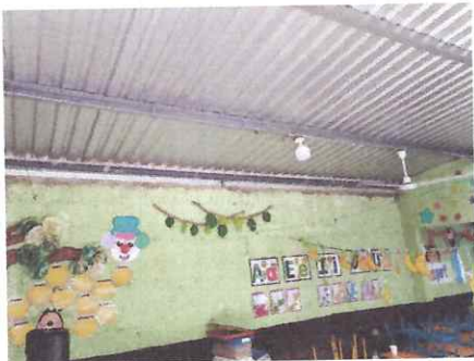
Foto: 1, Impermeabilización, pintura y cableado eléctrico y sustitución de plafoneras con focos.
