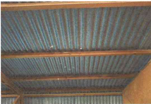
Foto: 3 agujeros tapados con silicon en inviernos anteriores
