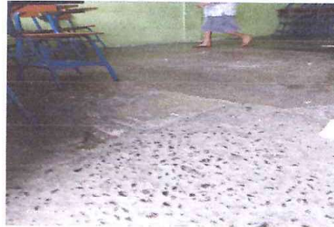
Foto: 2 INSTALACIÓN DE PISO EN AULAS
