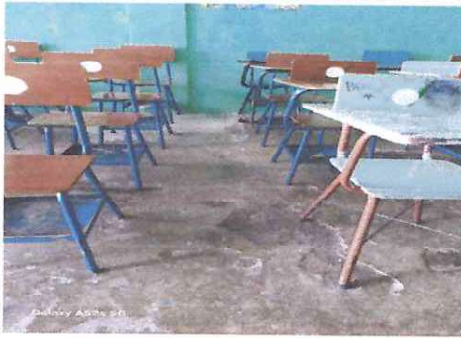
Foto: 1 INSTALACIÓN DE PISO EN AULAS
