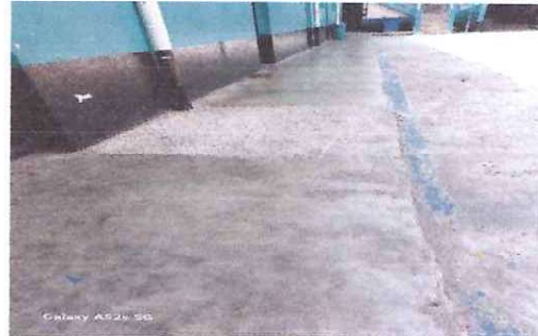
Foto: 8 INSTALACIÓN DE PISO EN CORREDORES
