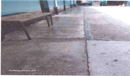
Foto: 7 INSTALACIÓN DE PISO EN CORREDORES
