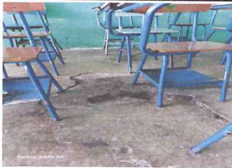
Foto: 3 INSTALACIÓN DE PISO EN AULAS
