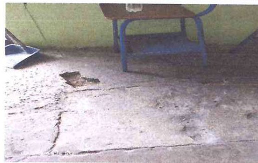
Foto: 4 INSTALACIÓN DE PISO EN AULAS
