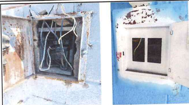
Foto: 1 Corrección en tablero
