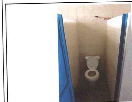
Foto: 5 Mejoramiento en sanitario
