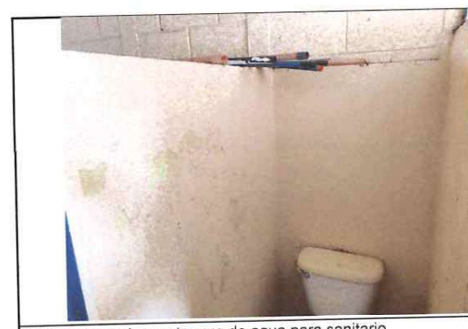
Foto: 6 correccion en tanque de agua para sanitario
