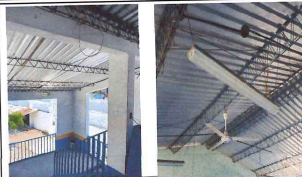
Foto: 2 Mejoramiento del sistema eléctrico
