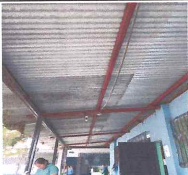
foto 1 CAMBIO DE LÁMINA DE CORREDOR PEQUEÑO
