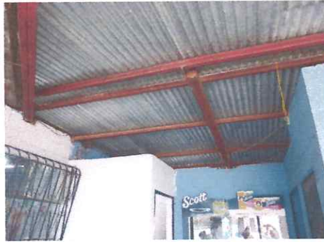
Foto: 2 CAMBIO DE LÁMINA DE BAÑOS Y CORREDOR
