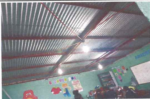
Foto: 3 CAMBIO DE LÁMINA DE 2 SALONES Y 2 DIRECCIONES
