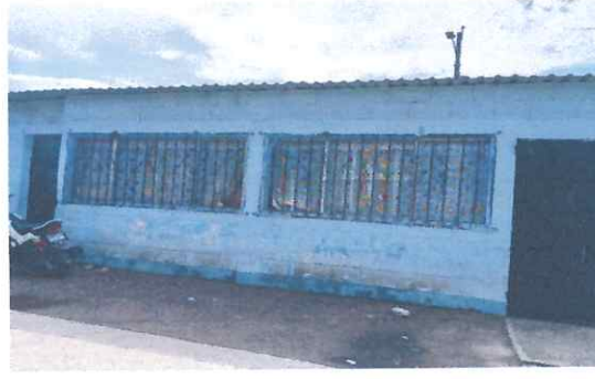
Foto: 4 CAMBIO DE VENTANAS MARCO DE METAL POR PVC Y VIDRIO TRANSPARENTE
