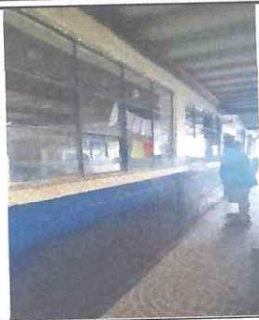
Foto: 1 cambio de ventanales planta alta
