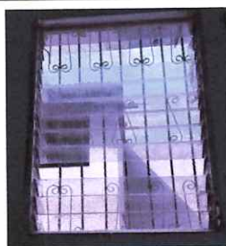
Foto: SUSTITUCIÓN DE ESTRUCTURA DE METAL DE VENTANA
