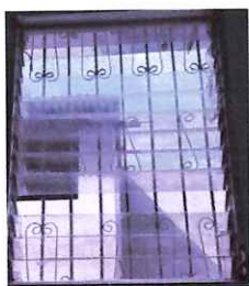
Foto: SUSTITUCIÓN DE ESTRUCTURA DE METAL DE VENTANA
