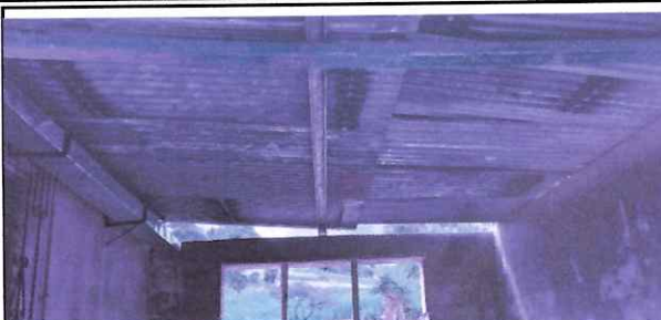
Foto: SUSTITUCIÓN DE LÁMINA, POR LÁMINA TROQUELADA ALUZINC CALIBRE 26
