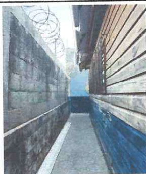
Foto: 3. MANTENIMIENTO DE PARED DE MADERA Y REMODELACION
