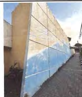
Foto: 6, Pintura para muros exteriores en fachada principal..
