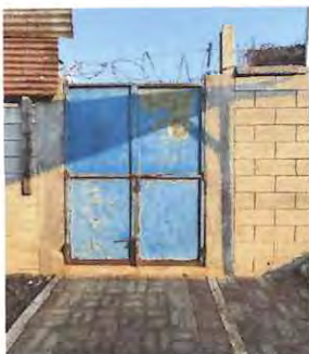
Foto: 3, Sustitucion de porton secundario.
