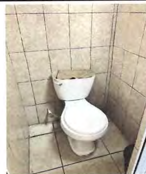
Foto: 2, Kid para inodoro, mantenimiento de deposito de agua.
