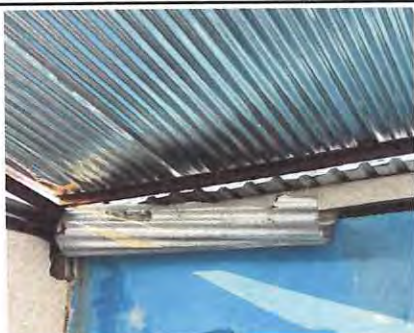
Foto: 5, Suministro e instalacion de canales.
