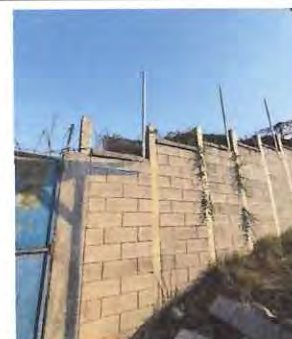
Foto: 4, Mejoramiento se cerco perimetral por seguridad.
