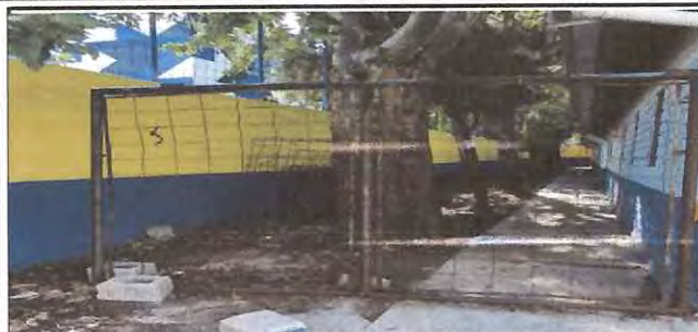
Foto: 1 Sustrucción de portón en área verde.
