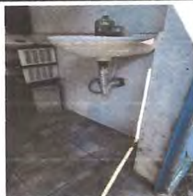
Foto: 11 Fuga de agua por daño en la tubería del lavamanos de docentes
