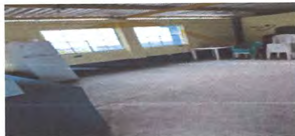
Foto: 12 Sustitución de piso en la cocina
