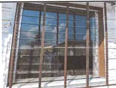
Foto: 5 Sustrucción de vidrios
