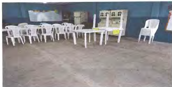
Foto: 13 Sustitución de piso en salón de Emprendimiento
