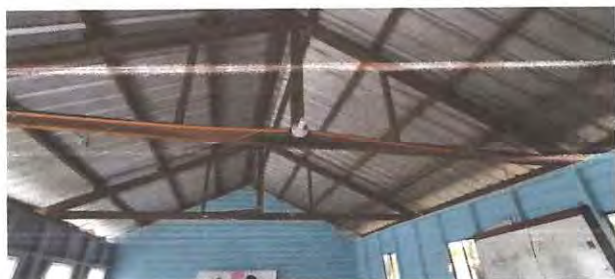
Foto: 9 Reparación del Sistema Eléctrico
