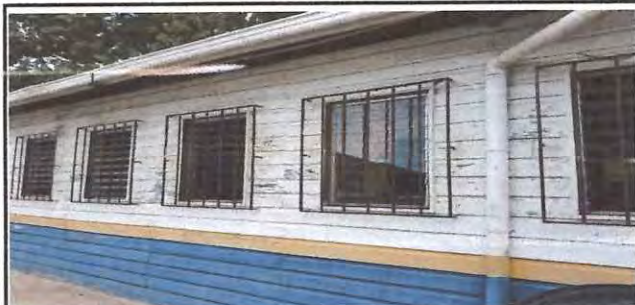
Foto: 3 Mantenimiento de ventanas
