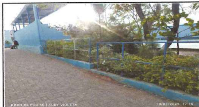
Foto: 9 mantenimiento de baranda de jardin, reforzamiento y pintada
