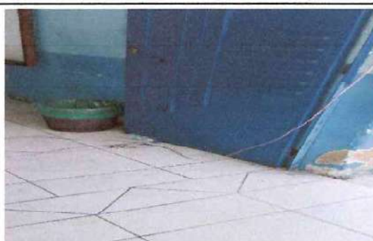
Foto: 2 remosamiento de puertas, cambio de chaspas y rectificaciom de pasadores y pines y pintado
