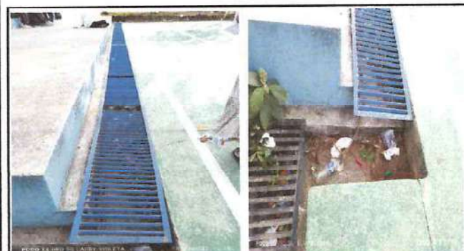
Foto: 11 remozamiento de cuneta cancha
