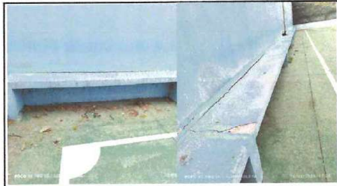
Foto: 12 remozamiento de banquetas de cancha
