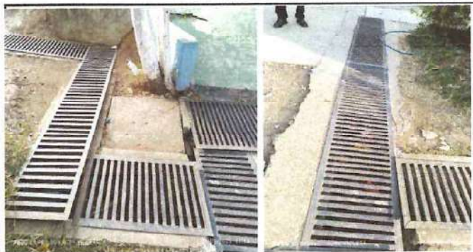
Foto: 7 remozamiento de cuneta frente a sanitarios
