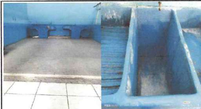
Foto: 8 remozamiento de pilas, colocacion de piso ceramico y azulejo a ambas pilas
