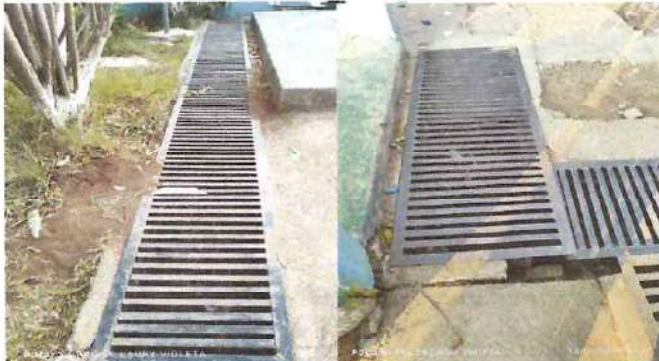
Foto: 10 remozamiento modificacion de rejas de cuneta de jardin
