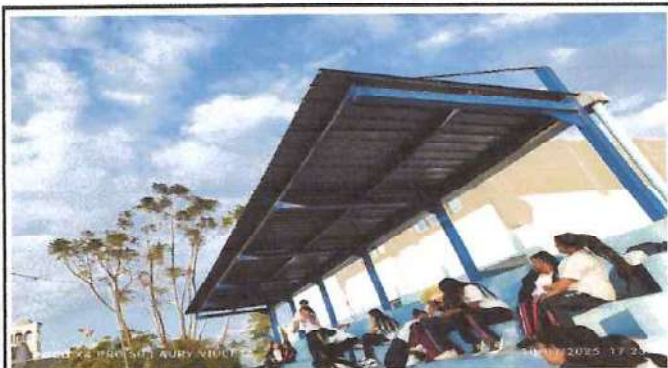
Foto: 13 remozamiento de canal pluvial en graderio
