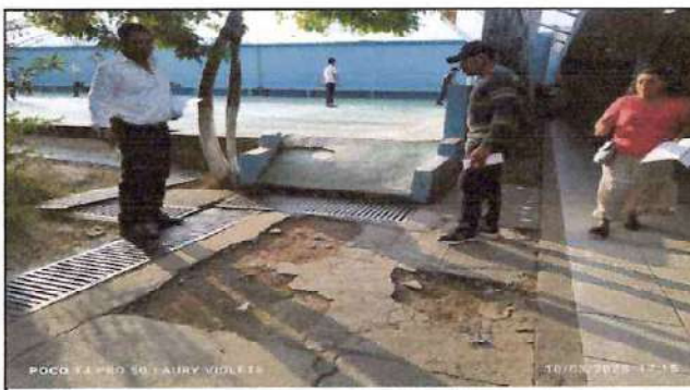
Foto: 6 loza frente a sanitarios
