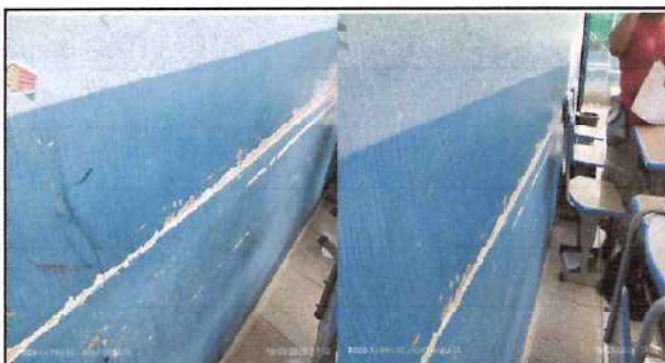
Foto: 3 remozamiento de aulas con repello y colocar protector de lamina
