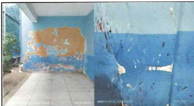
Foto: 15 remosamiento de pintura en interior y exterior de aulas modulo principal
