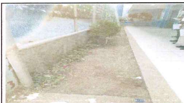
Foto: 5 arriate area jardin, colocacion de block y colocacion de piedrin
