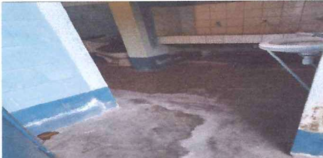
Foto 4 segundo sanitario para cambio de azulejo y chorros
