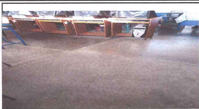
Foto 1 2 salones para colocar piso granito
