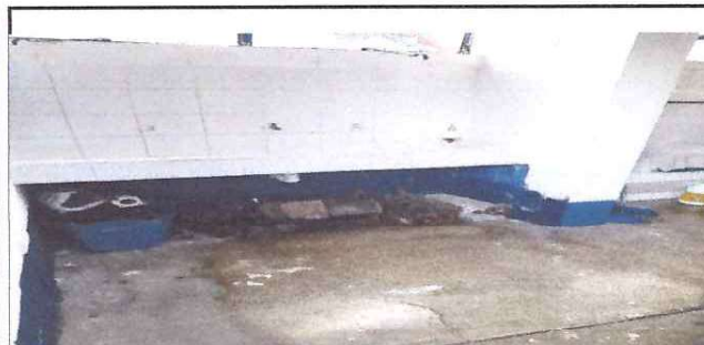
Foto 3 dos sanitarios para piso granito e instalación de un inodoro
