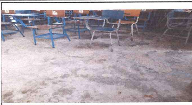
Foto 2 1 salón del segundo nivel para piso granito
