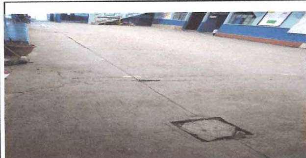
Foto: 3 Nivelacion y colocacion de piso baldosa granito.
