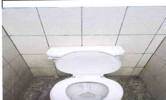
Foto: 6 Cambio de sanitarios defectuosos.
