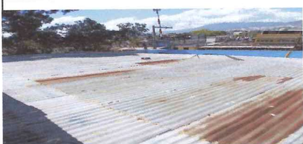
Foto: 1 Cambio de techo de las aulas de enfrente.
