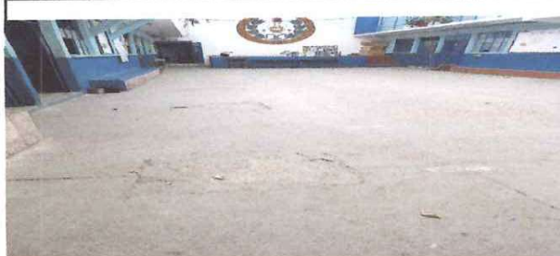
Foto: 4 Nivelacion y colocacion de piso baldosa granito.
