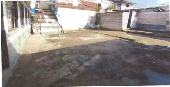
Foto 1: Sustrución de concreto en patio
