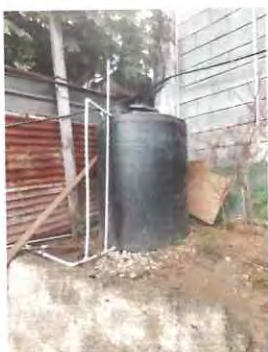
Foto 3: Sustrución de deposito de agua
