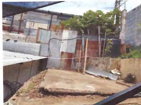
Foto 2: Sustrución de concreto en patio
