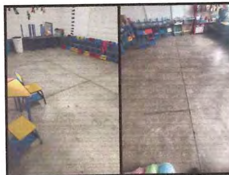
Foto 6: Instalacion de piso ceramico
