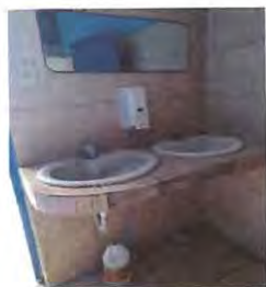
Foto: 1 cambio e instalación de azulejo en lavamanos de sanitarios de niños y niñas. Y cambio total de 4 lavamanos.
