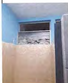
Foto: 3 sustitucion de ventanas por blok y repello en baños de niños y niñas.
