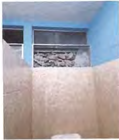
Foto: 3 sustitucion de ventanas por blok y repello en baños de niños y niñas.
