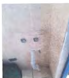
Foto: 6 Cambio y sustitucion de sanitario de maestros, sustitucion de lavamanos.
