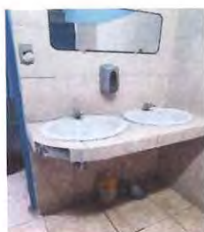
Foto: 1 cambio e instalación de azulejo en lavamanos de sanitarios de niños y niñas. Y cambio total de 4 lavamanos.
