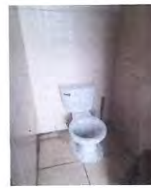
Foto: 6 Cambio y sustitucion de sanitario de maestros, sustitucion de lavamanos.
