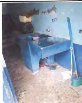
Foto: 5 suministro e instalacion de pila.
