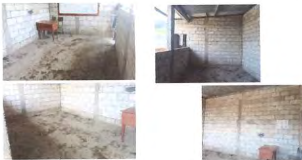
Foto: 2, Cernido en pared, mantenimiento de torta de concreto e instalacion de piso ceramico.
