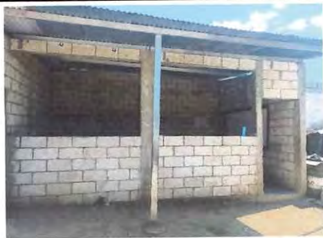
Foto: 3, Cernido de pared, refuerzo de viga dintel mas torta de concreto en patio.
