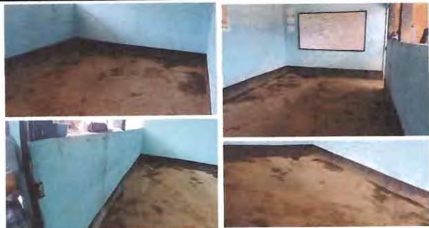
Foto: 1, Mantenimiento de torta de concreto e instalacion de piso ceramico.
