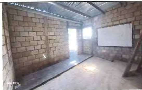
Foto: 4, Mejoramiento de torta de concreto en salon docente, Cernido en pared.
