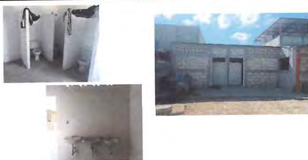
Foto: 5, Sustitucion de sanitarios y lavamanos, instalacion de piso ceramico e instalacion de puertas interior y exterior.
