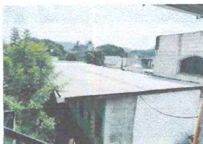
Foto 5: Cambio de lamina por lamina troquelada
