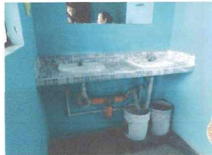
Foto 2: Mantenimiento a lavamanos.
