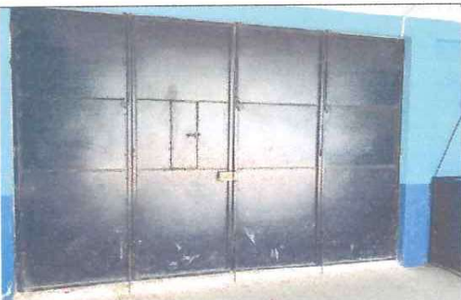
Foto: 3 Mantenimiento de portón
