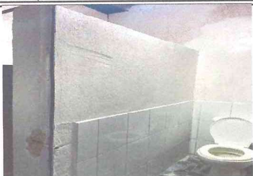
Foto: 1 Completar piso cerámico en pared de baños
