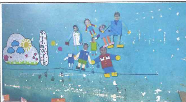
Foto: 4 Cambio de cerrido en salones
