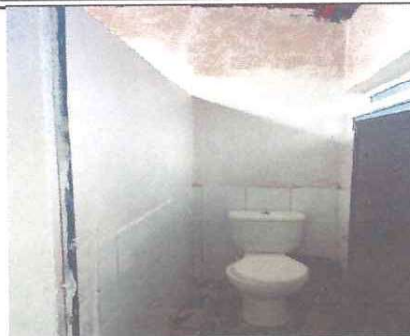
Foto: 2 Completar piso cerámico en pared de baños
