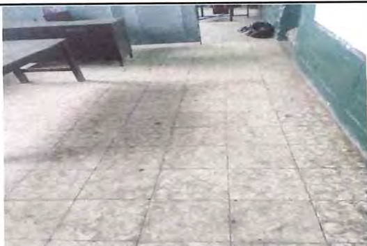
Foto: 1 Remozamiento de piso, repello y cernido del salón.
