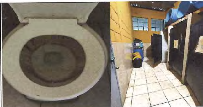
Foto: 6 Cambio de sanitarios, mantenimiento de puertas de metal, azulejo en sanitarios, repello y cernido.
