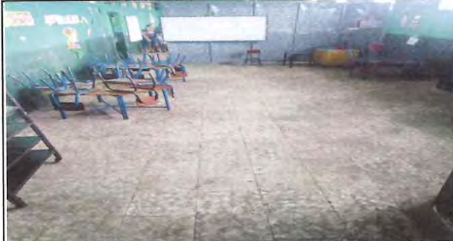
Foto: 2 Remozamiento de piso, portones, paneles divisores, repello y cernido.
