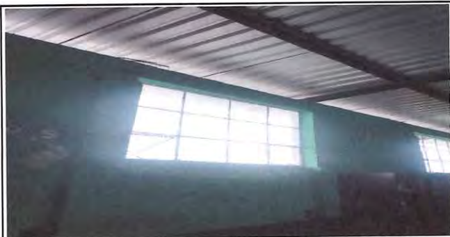
Foto: 5 Retiro de ventanas de hierro, cernido y repello, instalación de ventanas PVC, (ventilación cruzada)
