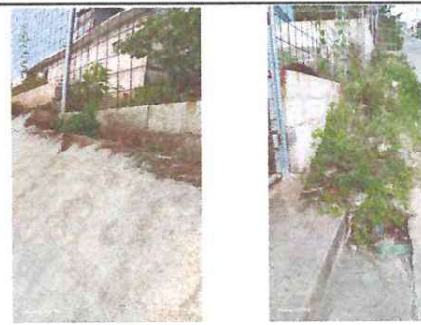
Foto: 4 Cerrido de Muro y reparacion de banqueta
