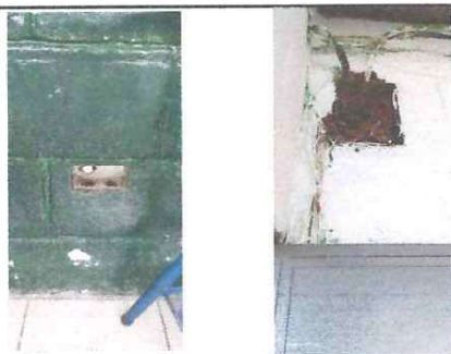
Foto: 3 Cambio de unidades de tomacorrientes y caja de filpones
