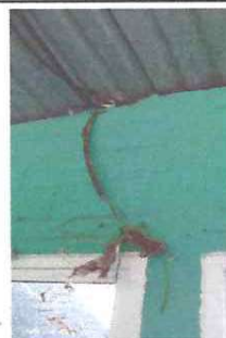
Foto: 2 Mejoramiento en sistema eléctrico
