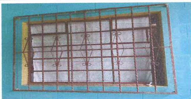
Foto: 5 DESMONTAJE Y MANTENIMIENTO DE BALCONES
