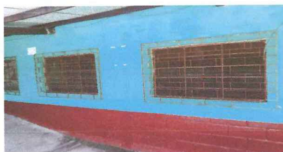
Foto: 4 SUSTITUCION DE VENTANAS DE METAL POR PVC
