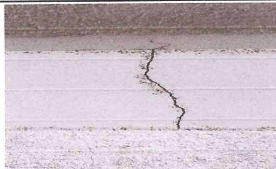
Foto: 2 REFORZADO DE LOZA SEGUNDO NIVEL
