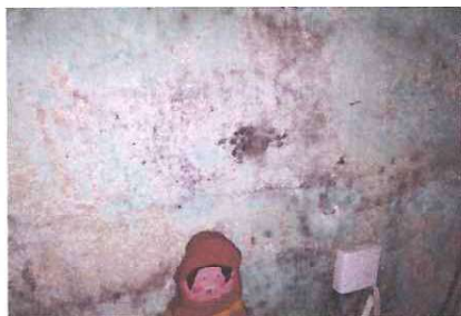
REPARACIÓN DE HUMEDAD EN DIRECCIÓN
