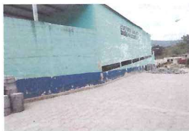
Foto: 6 PINTURA EXTERIOR DEL INSTITUTO
