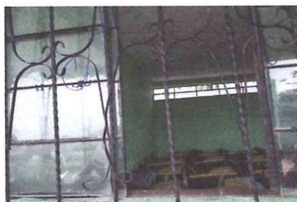
Foto: 3 REPARACIÓN, PINTURA DE BALCONES Y COLOCACIÓN DE BLOCH DE VIDRIO
