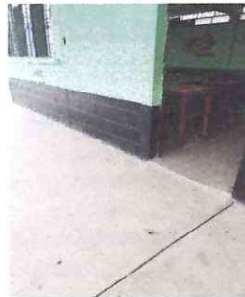
Foto: 2 NIVELACIÓN Y COLOCACIÓN DE PISO CERÁMICO EN LAS AULAS Y PASILLO
