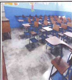
Foto 1 : Piso actual de 4to. B y C
