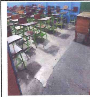
Foto 2: Piso actual 1ro. A y 2do. B
