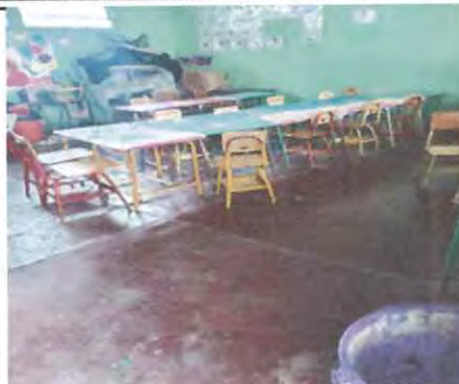
Foto 2: colocación de piso en salones de preprimaria
