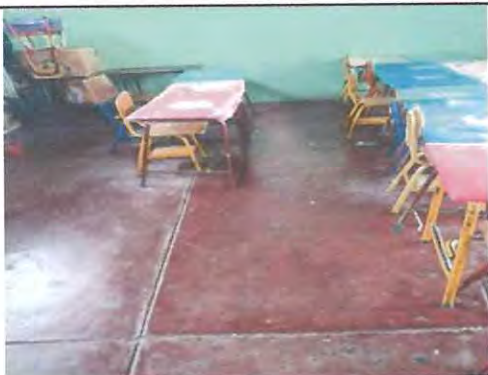
Foto: 3 Espacio para colocar piso ceramico en aula de preprimaria
