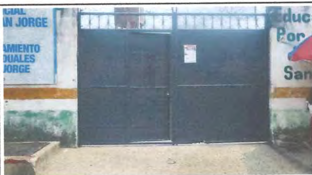
Foto: 5 REPARACION DE LA ESTRUCTURA DEL PORTON PRINCIPAL
