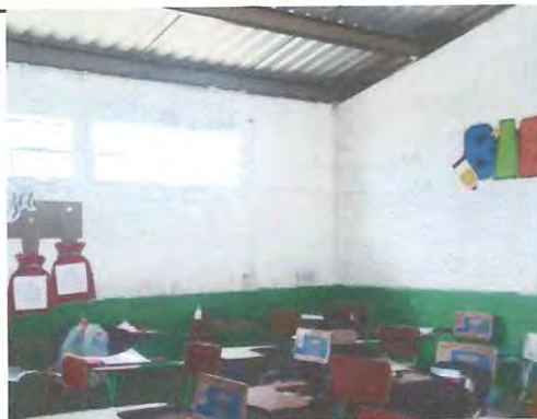
Foto 4: paredes a pintar del aula
