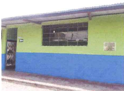
Foto 1: se hara sustitucion de piso de granito por piso semideslizante
