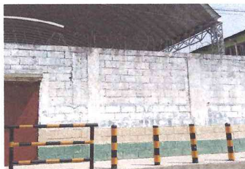
Foto 4: Se pintaran los muros exteriores, portones y se le pintara rotulos
