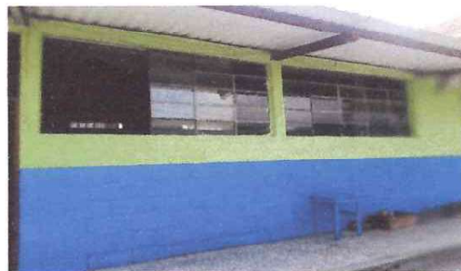
Foto 2: se hara sustitucion de piso de granito por piso semideslizante
