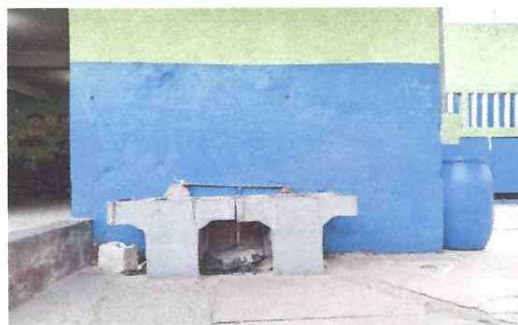
Foto 6: Desinstalacion de pilas e instalacion de lavamanos exteriores
