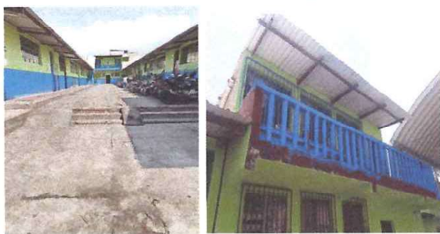
Foto 5: Instalación de canales con bajadas de agua pluvial.
