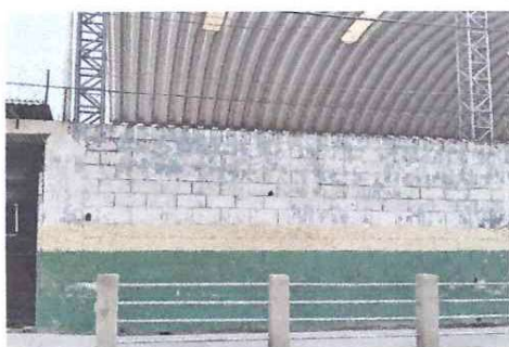
Foto 3: Se pintaran los muros exteriores, portones y se le pintara rotulos
