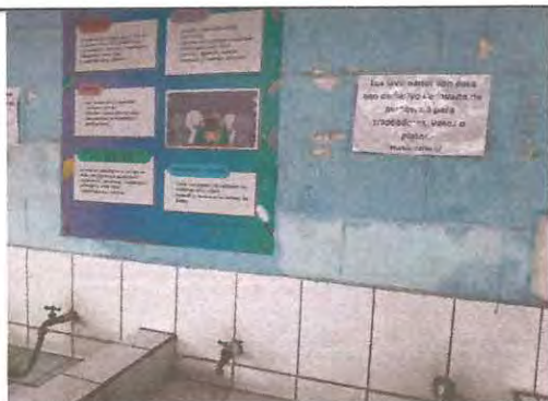
Foto: 5 EL ÁREA DE LA PARED SE ENCUENTRA DESCASCARÁNDOSE DEBIDO A LA HUMEDAD QUE SALPICA LA MISMA.
