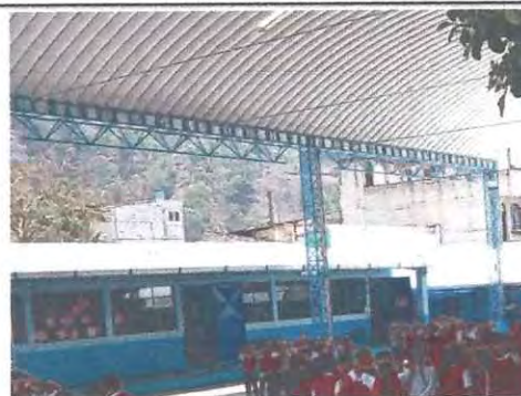
Foto: 6 MÓDULO DONDE SE COLOCARÁ EL FLASHING DEBIDO A QUE EN INVIERNO SE FILTRA EL AGUA DAÑANDO LAS PAREDES Y MATERIALES DIDÁCTICOS
