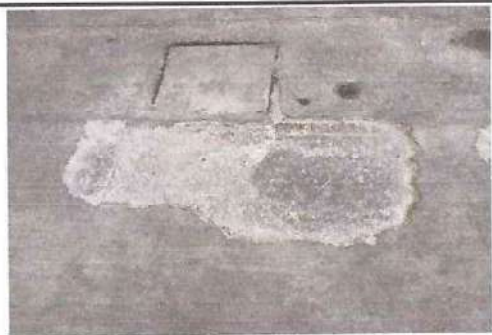
Foto: 5 Fundición de piso de concreto en la parte central del patio
