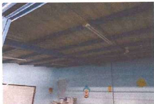
Foto: 3 Instalación de cielo Falso
