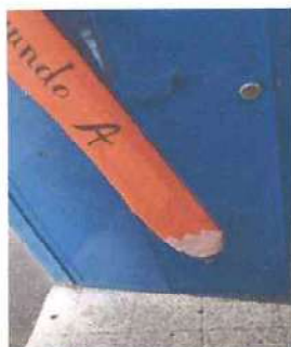
Foto: 9 Mantenimiento de puertas de aulas.
