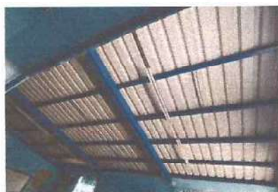
Foto: 17 Instalación de cielo falso en salon de clases de 6o. A
