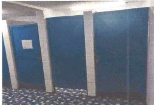
Foto: 8 Mantenimiento de puertas de sanitarios
