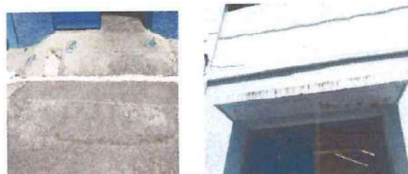
Foto: 4 aplicación de capa de concreto en el frente del centro educativo y filtración.
