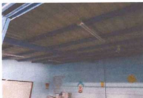
Foto: 15 Instalación de cielo Falso en salon de clases de 4o. A
