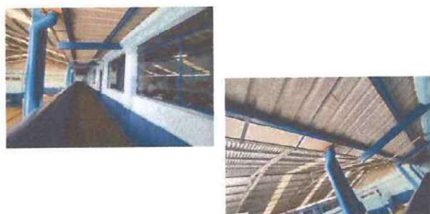
Foto: 11 Mantenimiento de canales y bajadas de agua.
