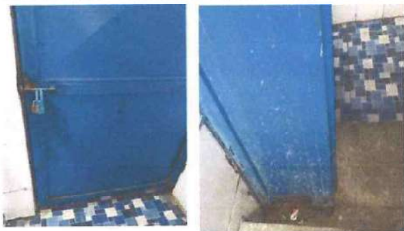
Foto: 7 mantenimiento de puertas de sanitarios
