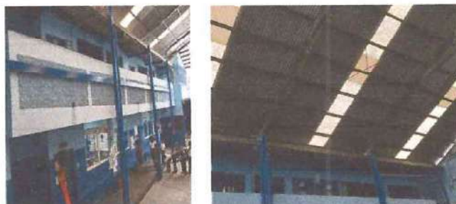
Foto: 4 Mantenimiento de bajadas y canal de agua
