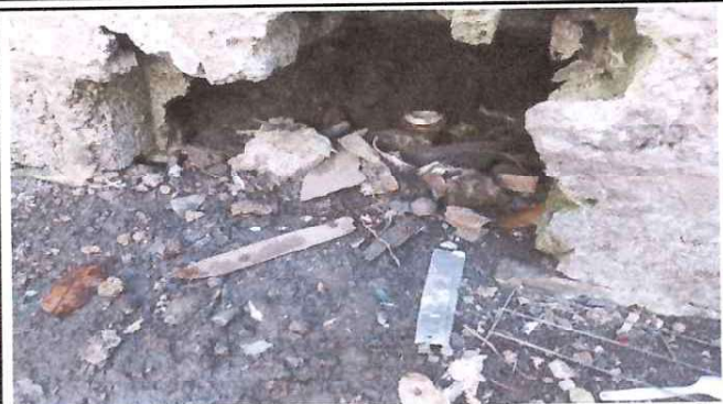
Foto: Reparación de drenaje
