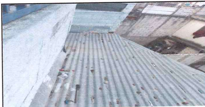
Foto: 6 Cambio de lamina
