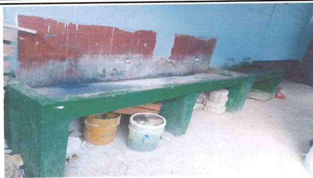
Foto: 2 Remozamiento en lavamanos
