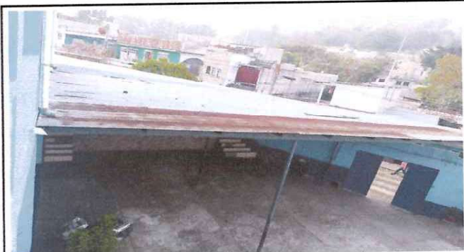
Foto: 3 Cambio de lamina
