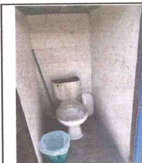
Foto 6: Sanitarios en mal estado, se hará sustitución de los mismos y se colocará piso cerámico
