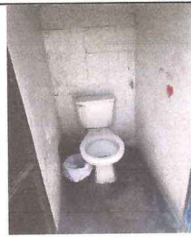
Foto 6: Sanitarios en mal estado, se hará sustitución de los mismos y se colocará piso cerámico
