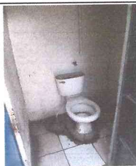
Foto 5: Sanitarios en mal estado, se hará sustitución de los mismos y se colocará piso cerámico
