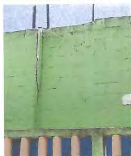
Foto1: Reparación y refuerzo de muro perimetral
