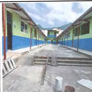
Foto 3: Reparación de planchas de concreto de patio
