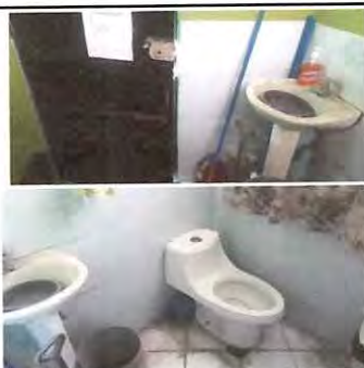
Foto 5: Cambio de sanitario y cambio de piso y azulejo
