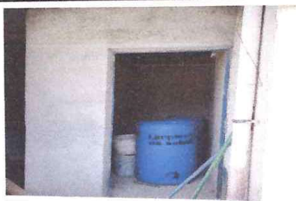
Foto: 5 SERVICIO SANITARIO Y SUS ACCESORIOS
