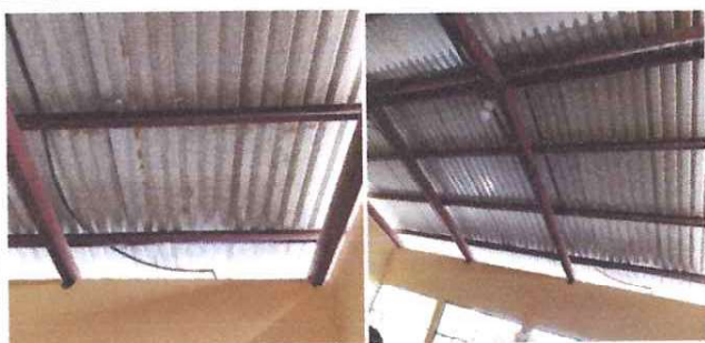
Foto: 1 CAMBIO DE TECHO, SALÓN 6o. PRIMARIA
