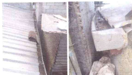
Foto: 4 REPARACIÓN Y MANTENIMIENTO DE TECHO Y CANALES 4o. GRADO Y DIRECCIÓN
