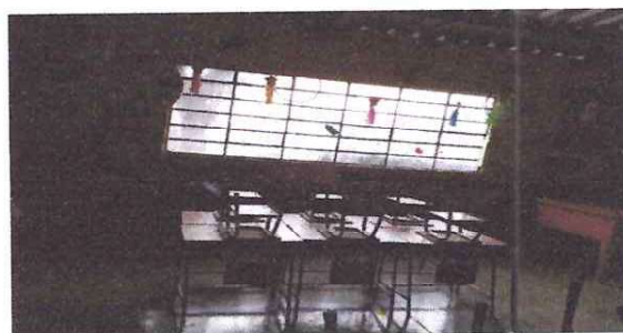
Foto: 6 REPARACIÓN DE VENTANA DE PARVULOS
