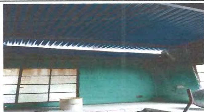
Foto: 3 Cambio de techado en cocina
