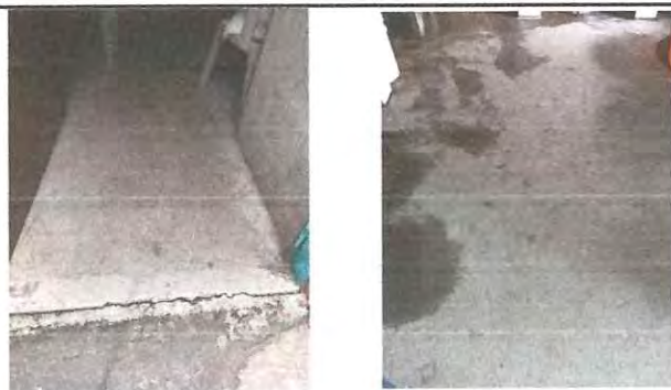
Foto: 5 Instalación de piso en cocina
