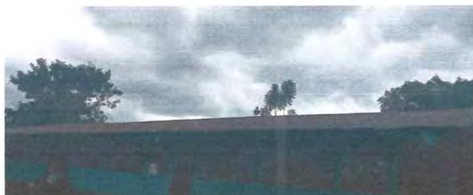
Foto: 1 Cambio de techado en modulo
