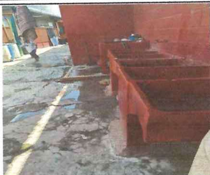
Foto 7: Forro de azulejo en las tres pilas.
