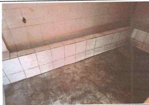
Foto: 4 Puesta de piso antideslizante migitorios y cambio de chorros.
