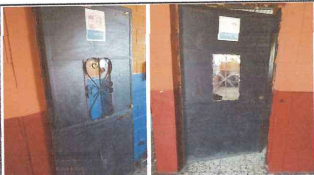
Foto 9: Reparación y mantenimiento de 15 puertas en módulo nuevo y planta baja.
