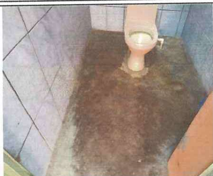
Foto: 1 Puesta de piso antideslizante tres baños de preprimaria
