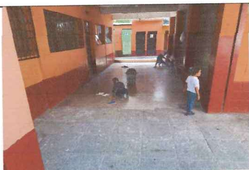
Foto: 3 Instalación de piso cerámico, corredor preprimaria.
