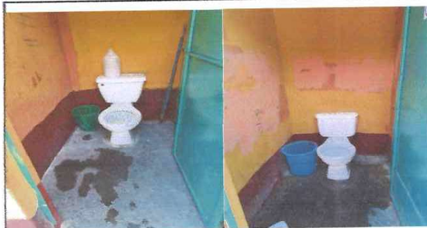
Foto: 2 Cambio de baños, piso antideslizante y azulejos seis baños de primaria
