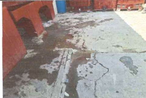
Foto 8: Fundición de Concreto
