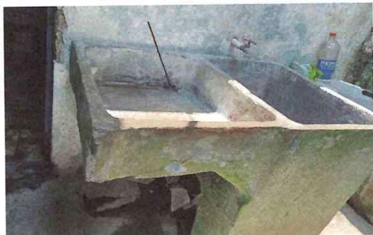
Foto 3: Cambio de pila
