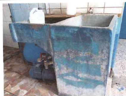
Foto 6: Pila en primer nivel
