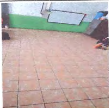
Foto 3: Piso Segundo "B"
