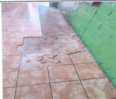
Foto 2: Piso segundo "A"
