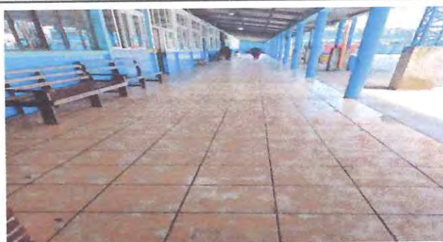
Foto 2: Piso del pasillo lado este-sur
