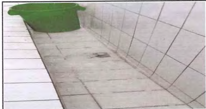
Foto: 6 reconstruccion de drenajes por taponamiento
