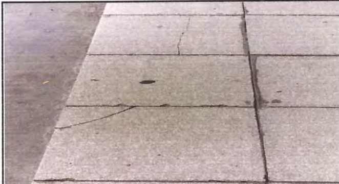
Foto: 2 cambio de pisos quebrados y despegados 20 metros
