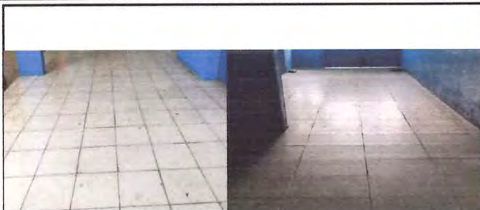
Foto: 1 remozamiento de 315 metros de piso en mal estado
