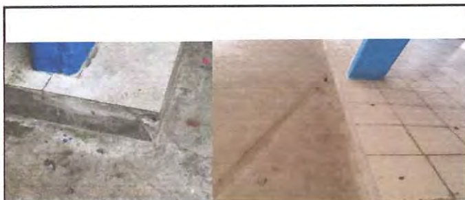
Foto: 3 colocacion de zocalo 57 metros
