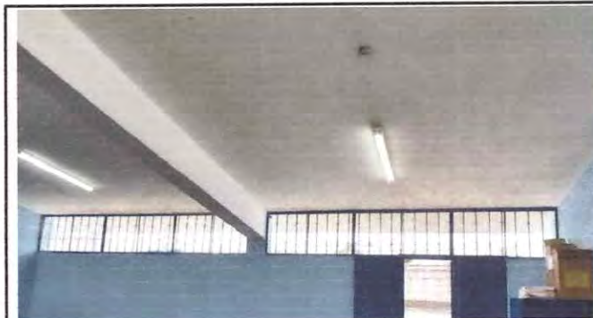
Foto: 4 cambio de ventanas 46 metros cuadrados, por ventanas por ventana corredizas PVC ventilables, con vidrio ahumado.
