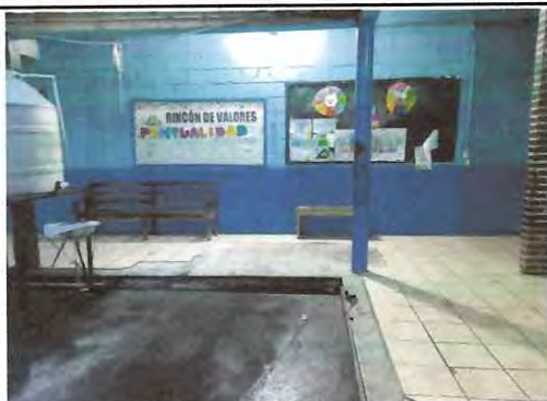
Foto 3: Piso lado norte-este
