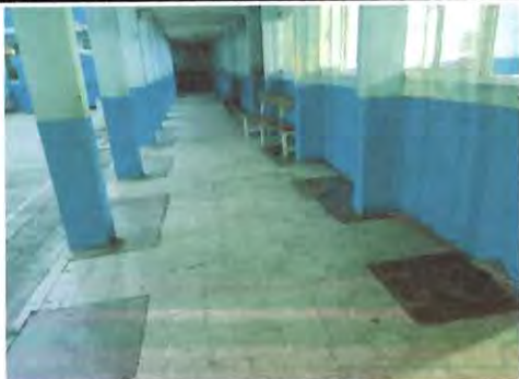
Foto 1: Piso del pasillo lado oeste-norte
