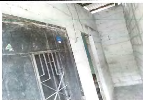
Foto 6: Arreglo de puertas de cocina
