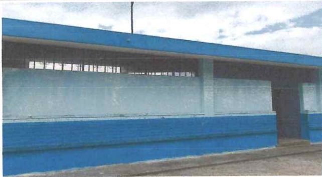
Foto: 1 cambio de ventanas segmentadas PVC corrediza bronce con refuerzo de aluminio a los laterales de 8 salones para mayor ventilación
