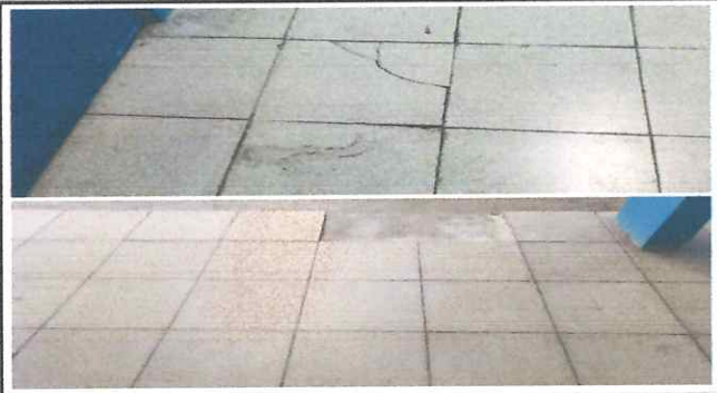
Foto: 2 corredor oeste sisado, llenado de sisa y cambio de pisos quebrados y levantados
