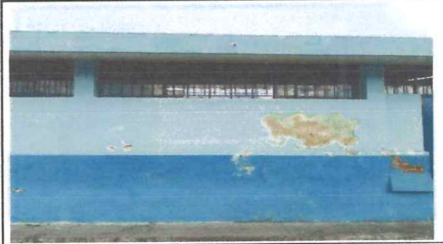
Foto: 4 Cambio de ventana PVC en ambos modulos de los baños para uso de ambas jornadas
