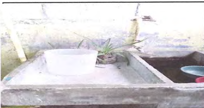
Foto: 5 AMPLIACION EN PILETA DE 1 CHORRO A 4 CHORROS
