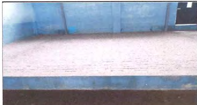
Foto: 4 IMPERMEABILIZANTE EN AREA DE ESCENARIO
