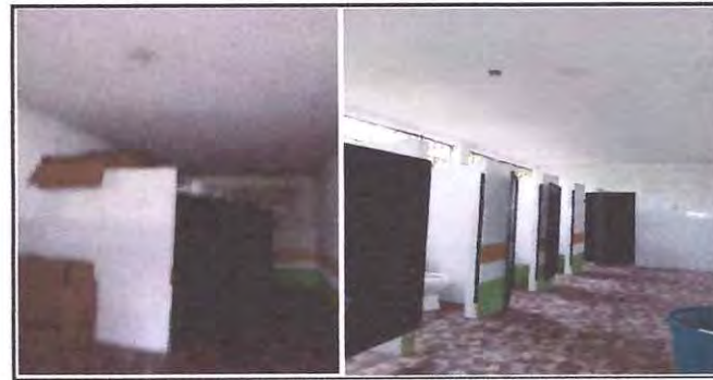
Foto: 6 AREA DE SERVICIOS SANITARIOS HOMBRES Y MUJERES
