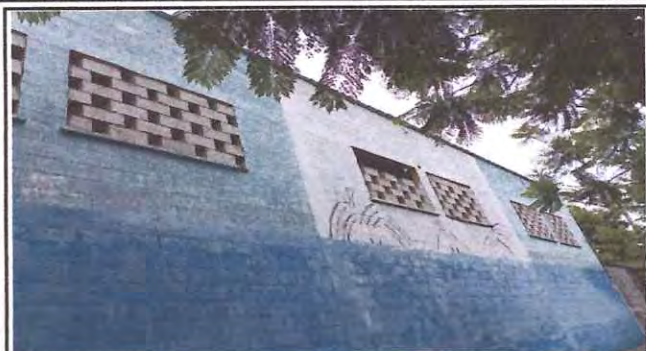
Foto: 1 SUMINISTRO E INSTALACION DE BALCONES 2DO NIVEL SALONES DE CLASE
