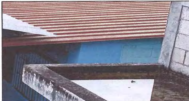
Foto: 2 CUBIERTA DE LAMINA PARA SALON DE CLASES
