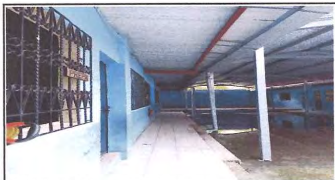
Foto: 3 CORREDORES PARA COLOCACION DE LAMPARAS (PATIO CENTRAL)
