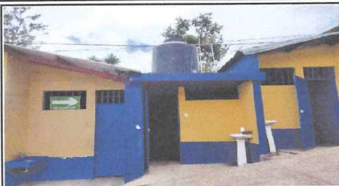
Foto: 7 mantenimiento de baños impermeabilización de paredes y terraza e instalación de canales y bajadas de agua.
