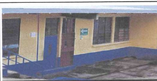
Foto: 11 mantenimiento correctivo de desfogue frente a las aulas No. 7 y No. 8
