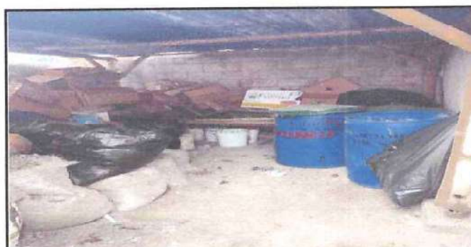
Foto: 12 mantenimiento correctivo de bodega, techo, piso, baño y fosa.
