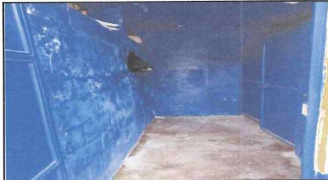
Foto No. 8 mantenimiento de baños impermeabilización de paredes y terraza e instalación de canales y bajadas de agua
