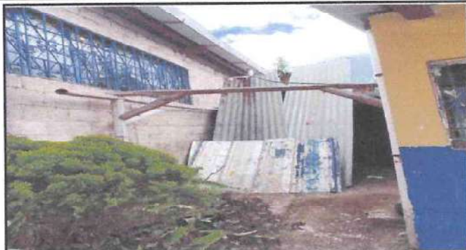
Foto: 13 mantenimiento corerectivo de bodega la puerta y el piso
