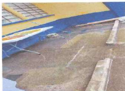
Foto No. 9 mantenimiento correctivo de desfogue frente a las aulas No. 7 y No. 8
