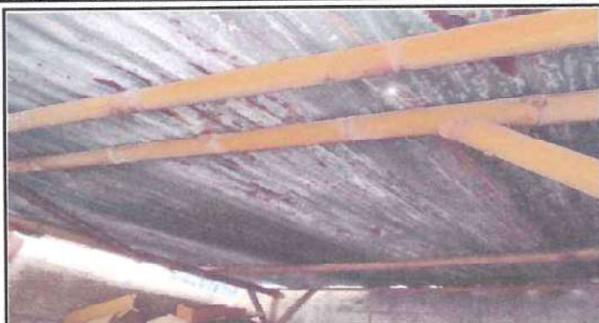
Foto No. 12 mantenimiento correctivo de bodega Techo
