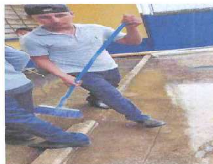
Foto No.10 mantenimiento correctivo de desfogue frente a las aulas No. 7 y 8.
