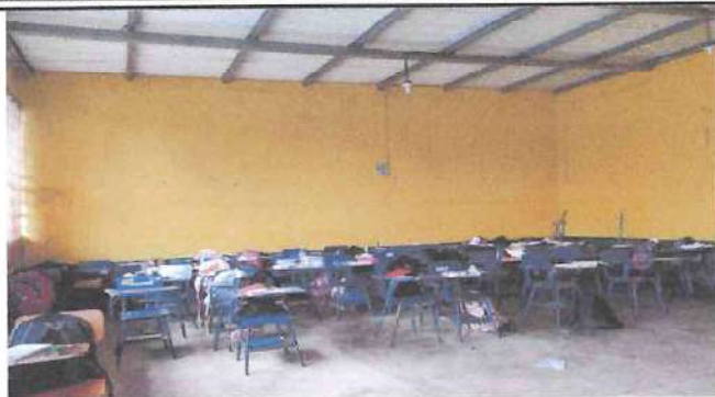
Foto: 1 Aula No. 7 Cerrido e impermeabilización
