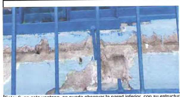
Foto: 6 en este ventana se puede observar la pared inferior con su estructura de revestimiento deteriorado dejando expuesta la mampostería o material de construcción.
