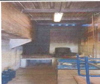
Foto: 7 mantenimiento de chimenea y azulejo de la cocina
