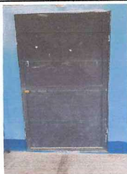
Foto: 9 pintura y mejoramiento de puerta de salones
