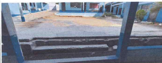
Foto: 4 mejoramiento de gradas de ingreso al patio
