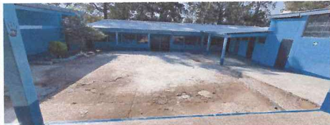
Foto: 1 Se da mantenimiento a torta existente
