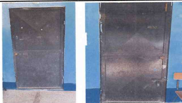
Foto: 6 pintura y mejoramiento de puerta de salones
