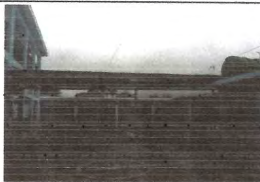
Foto: 4 Cambio de techo en pasillo
