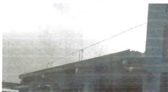
Foto: 5 Reparación de canales
