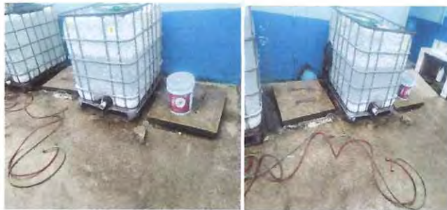
Reestructuración y reparación de cisterna
