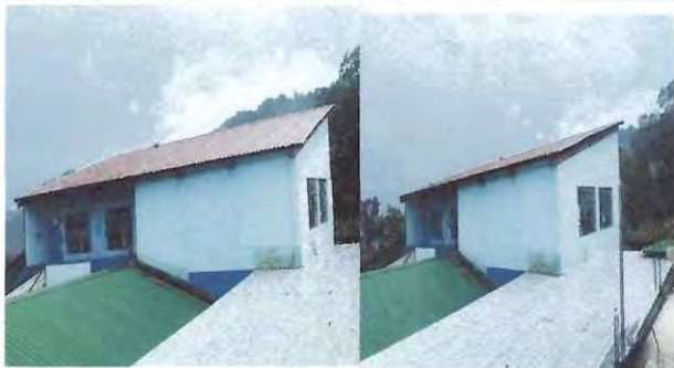
Cambio de techo en dos salones de clases
