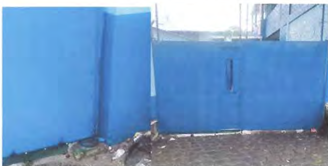
Reparación del portón de acceso
