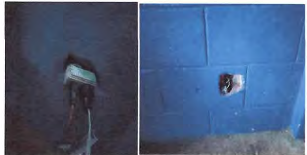
Reparación de tomacorrientes
