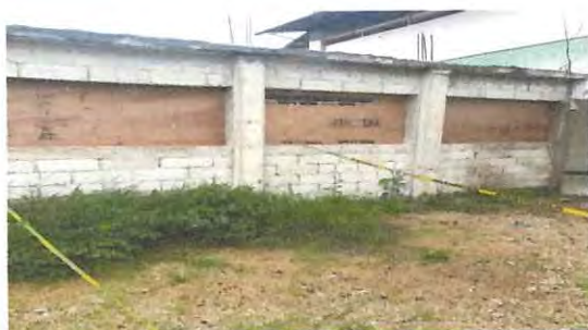
Foto 1: Mejoramiento de ventanas
