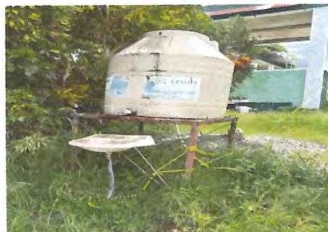
Foto 6: Refuerzo de estructura para deposito de agua
