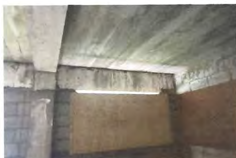
Foto 4: colocación de ventanas
