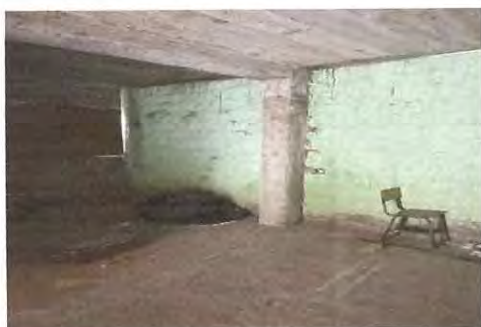
Foto 3: Mejoramiento de piso
