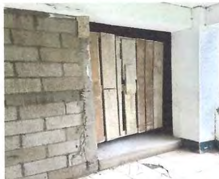
Foto 2: Aplicación de repello en paredes y colocación de puertas
