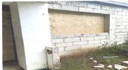
Foto 5: colocación de ventanas
