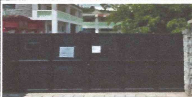
Foto: 5 Antes del reparación, mantenimiento y modificación
