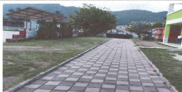
Foto: 6 Antes del reparación, mantenimiento y modificación
